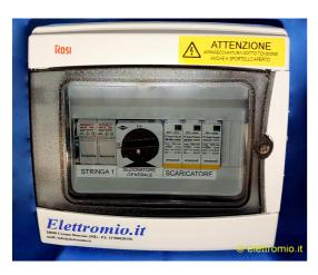
I Quadri DC sono indispensabili per garantire sicurezza all'impianto fotovoltaico. I quadri DC sono posti tra i moduli fotovoltaici e gli inverter e servono ad interrompere in caso di manutenzione il flusso di corrente continua verso l'inverter. Essi inoltre servono a proteggere l'impianto contro le sovracorrenti e sovratensioni.
