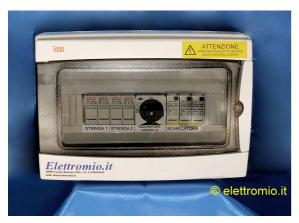
I Quadri DC sono indispensabili per garantire sicurezza all'impianto fotovoltaico. I quadri DC sono posti tra i moduli fotovoltaici e gli inverter e servono ad interrompere in caso di manutenzione il flusso di corrente continua verso l'inverter. Essi inoltre servono a proteggere l'impianto contro le sovracorrenti e sovratensioni.
