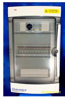
I Quadri DC sono indispensabili per garantire sicurezza all'impianto fotovoltaico. I quadri DC sono posti tra i moduli fotovoltaici e gli inverter e servono ad interrompere in caso di manutenzione il flusso di corrente continua verso l'inverter. Essi inoltre servono a proteggere l'impianto contro le sovracorrenti e sovratensioni.
