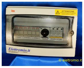
I Quadri DC sono indispensabili per garantire sicurezza all'impianto fotovoltaico. I quadri DC sono posti tra i moduli fotovoltaici e gli inverter e servono ad interrompere in caso di manutenzione il flusso di corrente continua verso l'inverter. Essi inoltre servono a proteggere l'impianto contro le sovracorrenti e sovratensioni.
